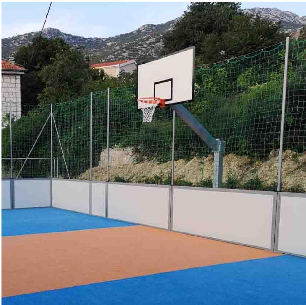
Struttura in tubolare di acciaio zincato a caldo sezione cm. 15x15, **sbalzo cm. 225**, completo di bussole in acciaio verniciato da interrare, **tabelloni in resina melaminica regolamentari cm.180x105** serigrafati colore bianco/nero, telaio di sostegno tabelloni in acciaio zincato a caldo, canestri e retine regolamentari.
